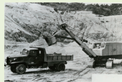
进行装载作业的机械式铲土机 (KB60型)
