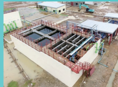
在迪拉瓦工业园区Zone A修建了净水厂
