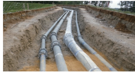
球墨铸铁管 用于给排水道和农业用水等基础设施。
