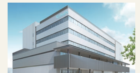
日本 枚方制造所内的综合楼(※正在修建)
