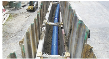
复合管 用作给排水道和煤气管道等基础设施。
