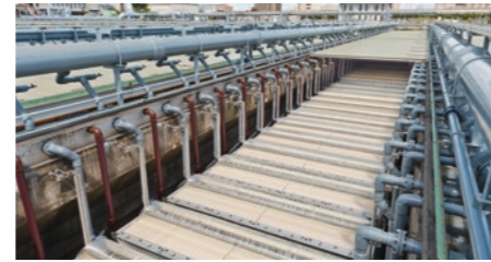
液中膜组件 对生活污水及工业废水等进行净化处理。
